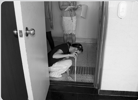
〈사진12〉 출입구(문) 단차, 점형블록의 설치방법 등 법적기준에 맞지 않게 설치되었다.
