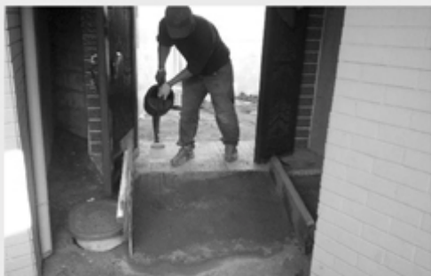
장애인 가구 현관문 접근로 경사로 설치 모습. ©대구시
