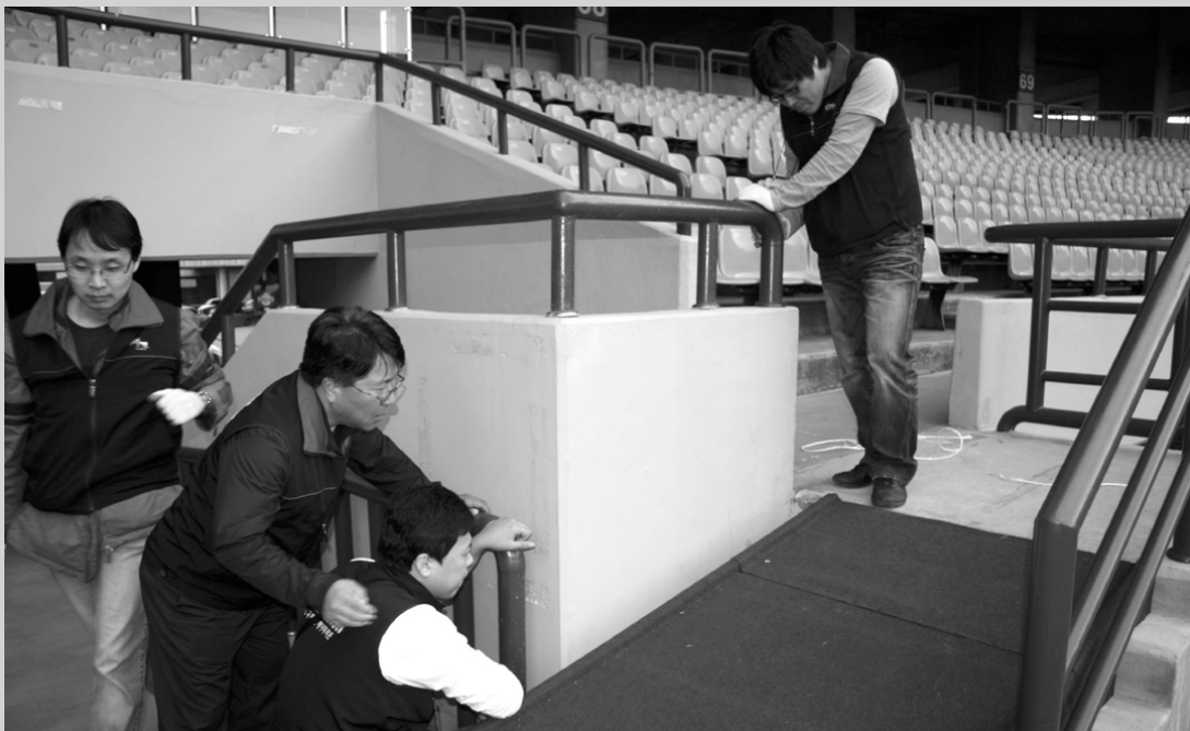
지체장애인편의시설지원센터 요원들이 서울국제휠체어마라톤대회가 열리는 잠실 주경기장의 관중석에 경사로를 설치하고 있다.
