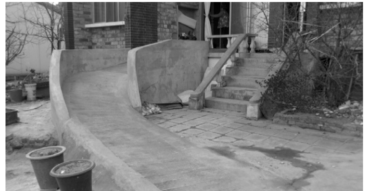
경상북도지체장애인협회 김천시지회에서 중증장애인가정에 설치한 콘크리트 경사로.
